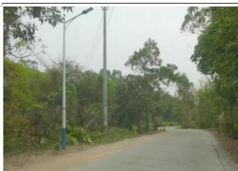
项目起点路段
