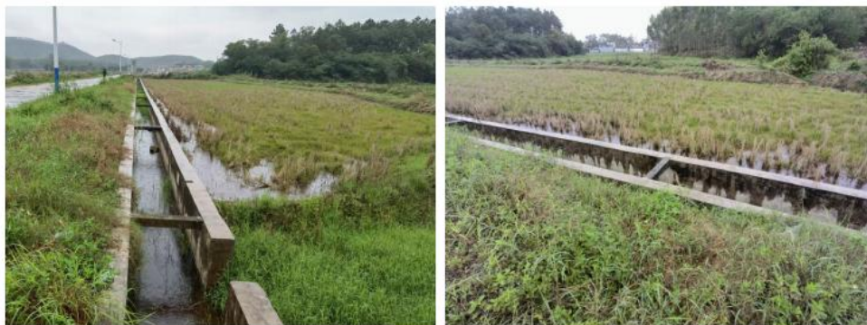
农田灌溉排水沟
